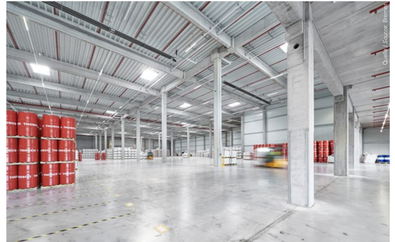
Logistikflächen im EPISO Logistikzentrum Hamburg / Logistics space in EPISO logistics centre Hamburg
