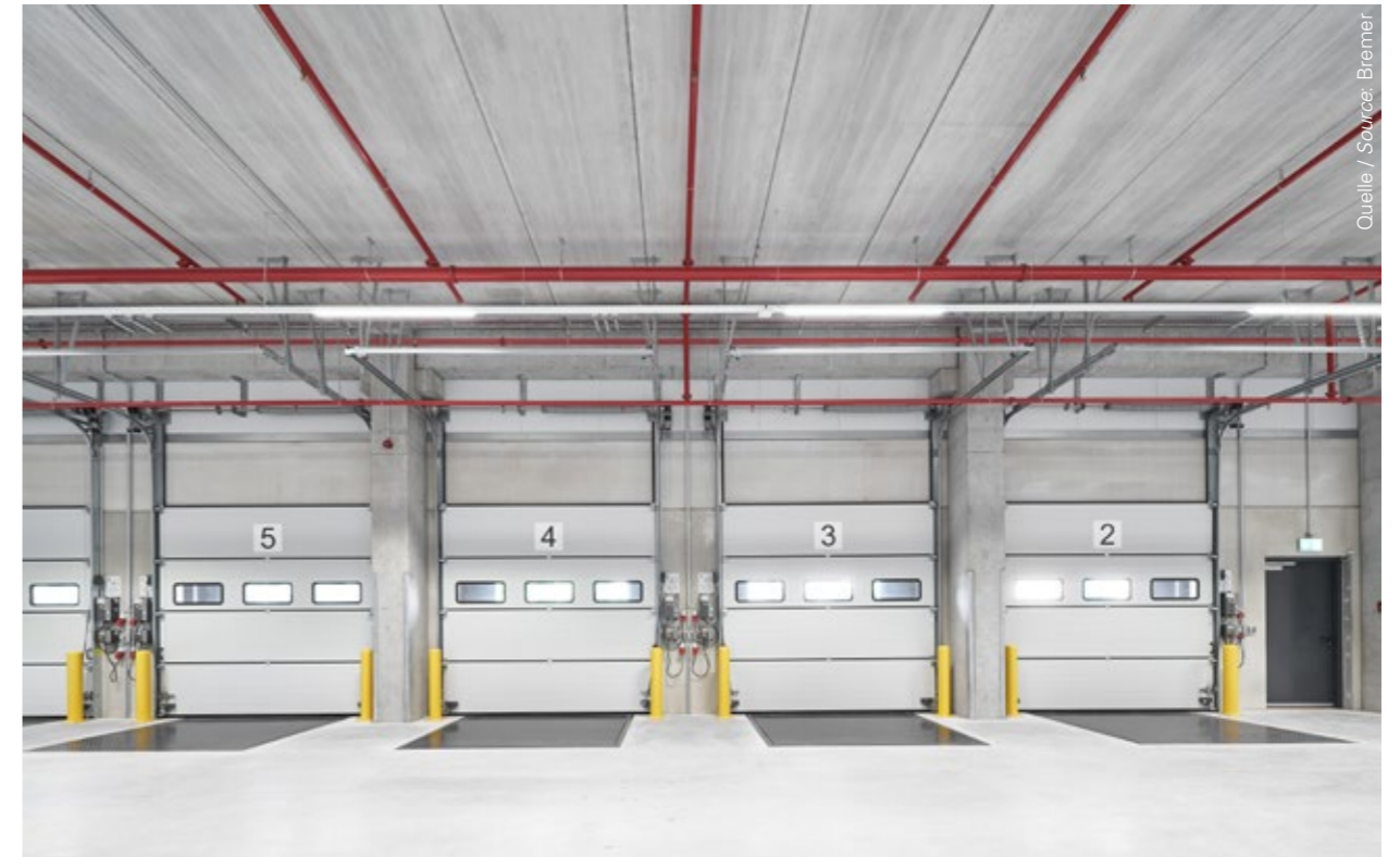
Ladefläche in einem Logistikzentrum / Loading area in a logistics centre
