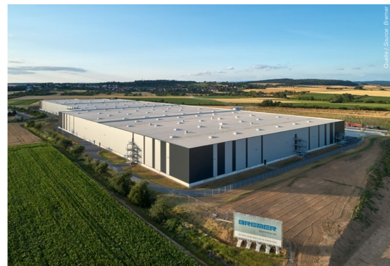
Luftaufnahme einer Distributionsimmobilie in Hammersbach / Aerial view of a distribution property in Hammersbach
