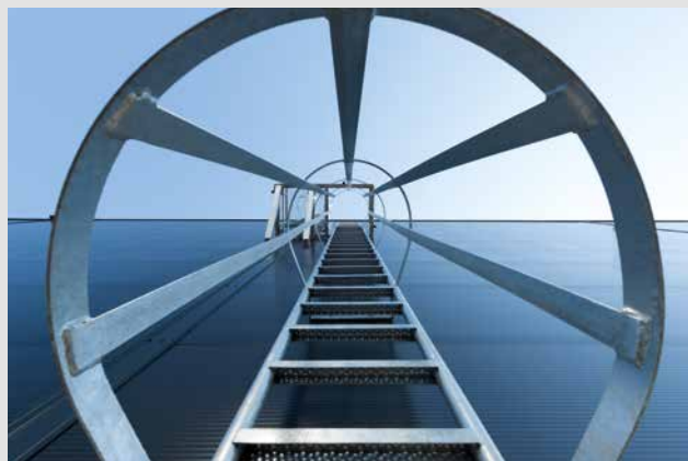
FEUERLEITER DES GREENFIELD LOGISTIKZENTRUMS IN ACHERN (Quelle: BREMER)
