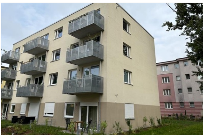
Neubau an der Neue Krugallee 22
