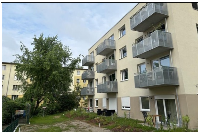
Neubau an der Neue Krugallee 22, Berlin-Plänterwald
