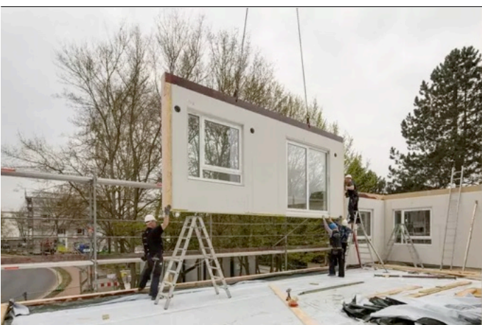
Serielle Holzbauweise Bremer Punkt Quelle: GEWOBA AG Wohnen und Bauen
