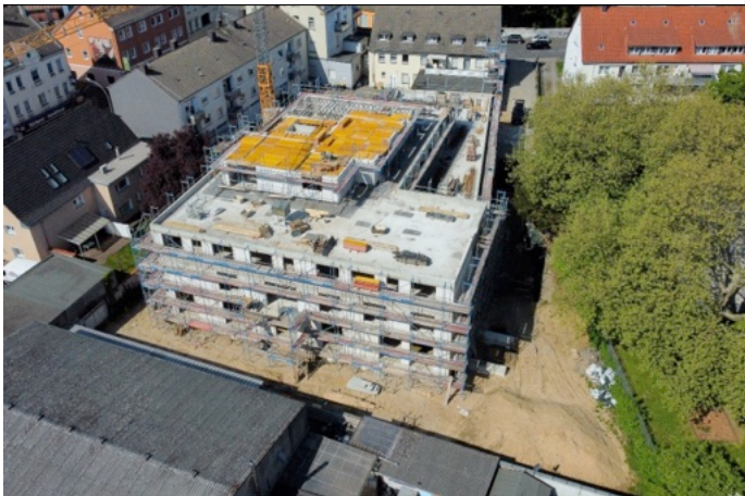
Rohbauphase Quelle: BAWOAG GmbH und Co KGaA
