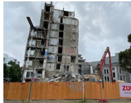
Beim Rückbau der alten Unternehmenszentrale orientierten wir uns am Konzept des Urban Mining. Die Idee dahinter: Bauschutt der Wiederverwendung und dem Recycling zur Verfügung zu stellen und die Stadt so zur Rohstoffmine werden zu lassen.
